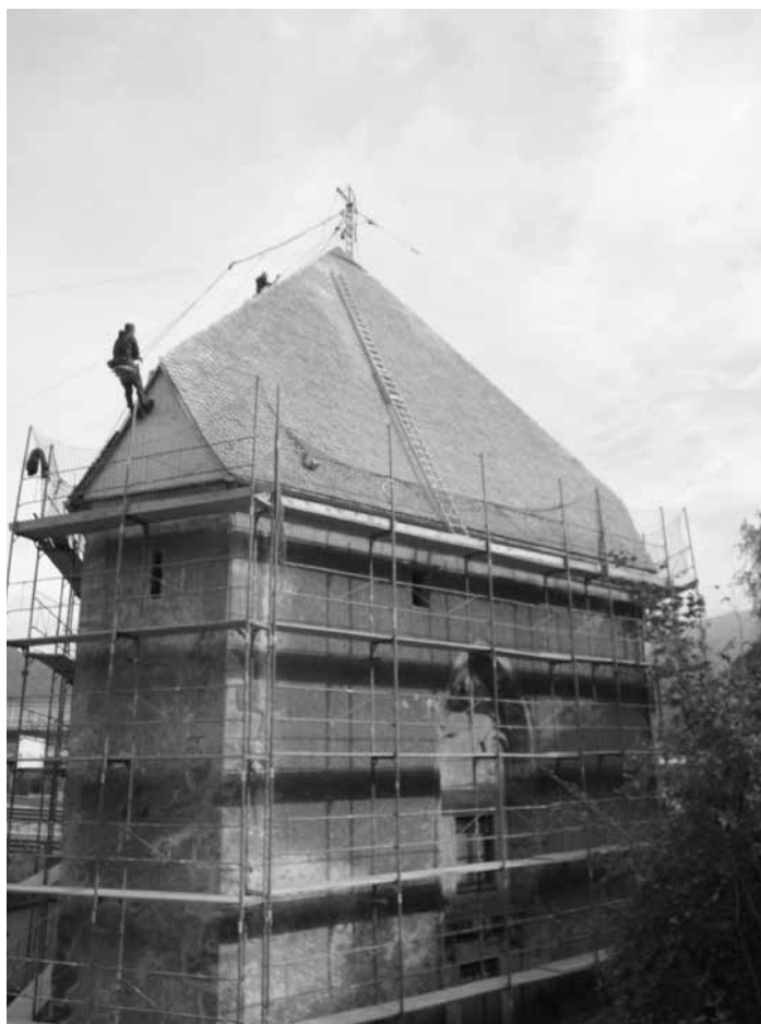
Die Dacharbeiten gestalteten sich sehr schwierig
