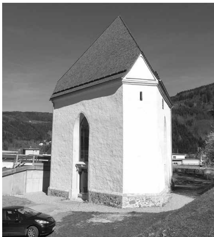
Nach der erfolgten Renovierung
