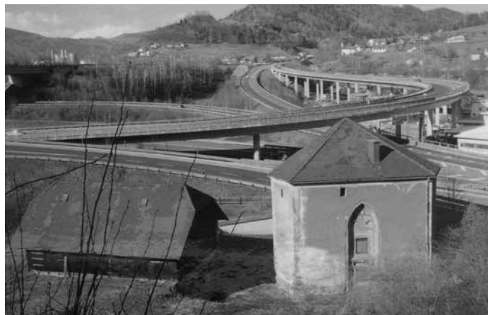
Die Heiligengeist-Kapelle umgeben von der „Straßenspinne“ vor der Renovierung
