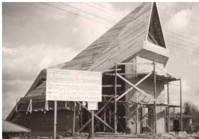
Die Gottscheer Gedenkstätte 1967 im Rohbau
