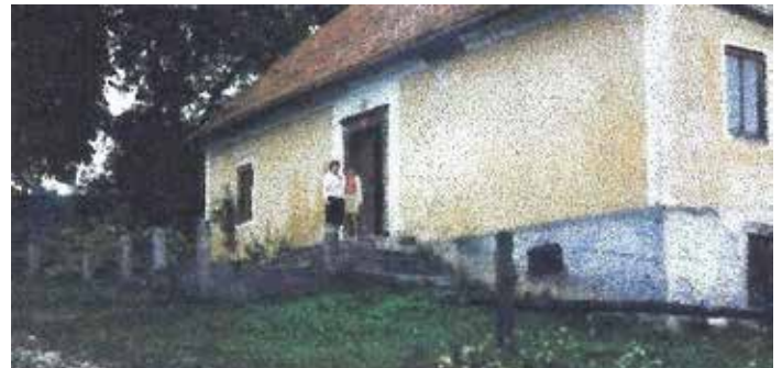
Die ehemalige Schule in Langenton
