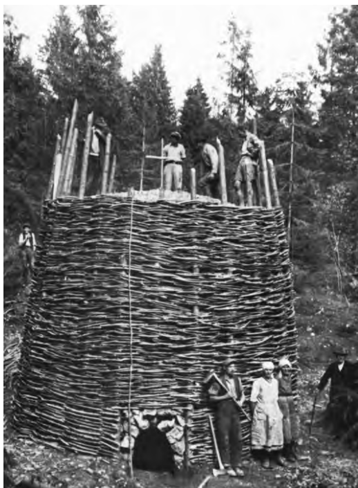
Errichtung eines Kalkofens Foto: Herbert Otterstädt
